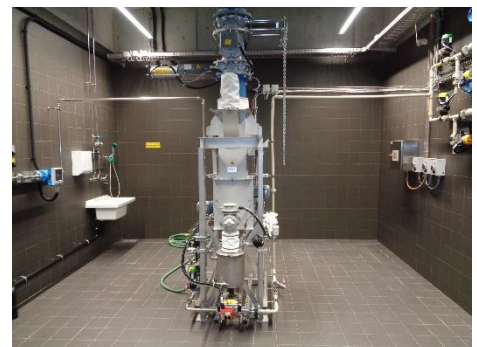
Pulveraktivkohle-Dosieranlage
