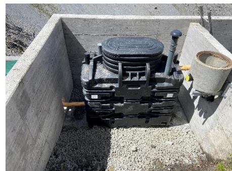
Mur de soutènement et installation avant remblayage
