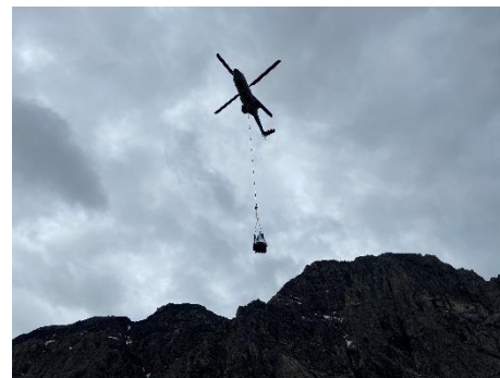
Transport des matériaux par hélicoptère
