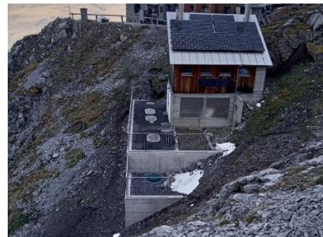
Petite station d'épuration terminée à côté du bâtiment des toilettes
