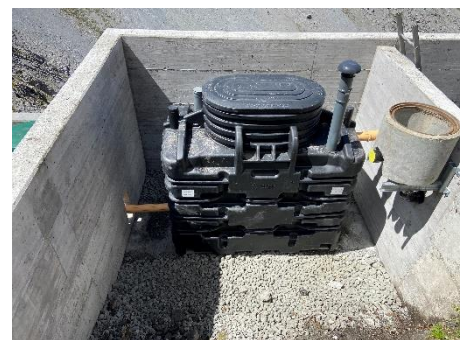
Stützmauer und Tropfkörper vor der Hinterfüllung
