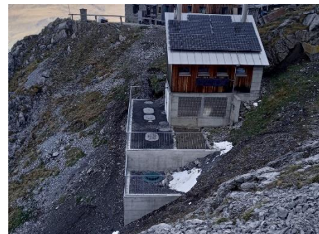
Fertige Kleinkläranlage neben dem WC-Gebäude
