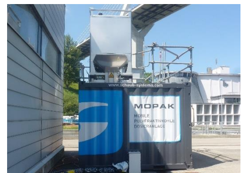
Installation der mobilen PAK-Dosierung (Schaub)
