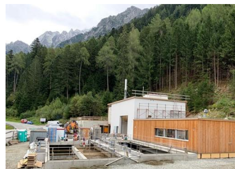
Bloc de bassins et bâtiments en construction
