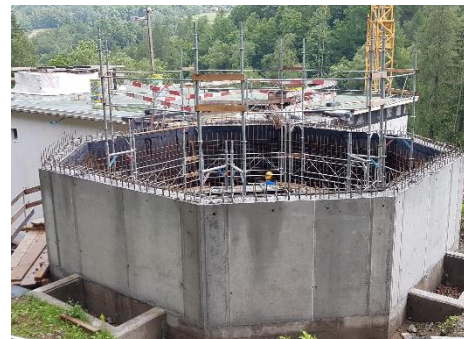
Transformation du bassin d'égouttage en fosse septique
