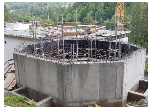
Umbau des Tropfkörperbeckens zum Faulraum
