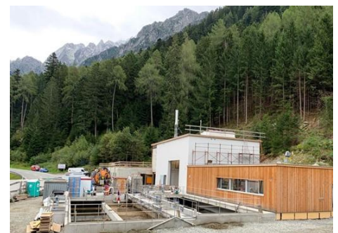
Beckenblock und neue Gebäude im Bau
