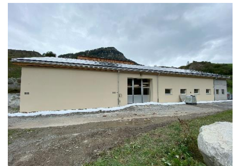
Façade et toit avec installation photovoltaïque
