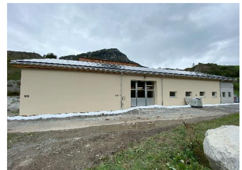
Fassade und Dach mit Photovoltaikanlage
