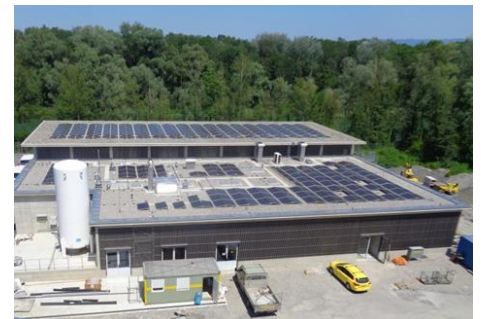
Ozonierung mit Sauerstofftank im Vordergrund, GAK-Filter im Hintergrund
