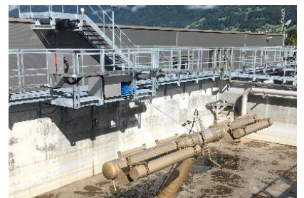
Blick in einen SBR-Reaktor
