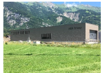
Blick auf das neue Betriebs- und Schlammgebäude
