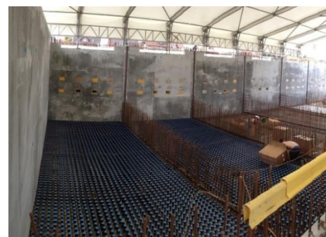
Construction du plancher à buses de la filtration
