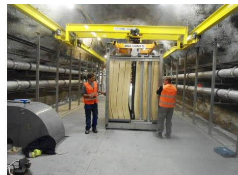
Cassette avec membranes avant la pose
