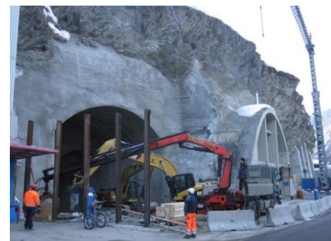
Travaux de forage dans la montagne
